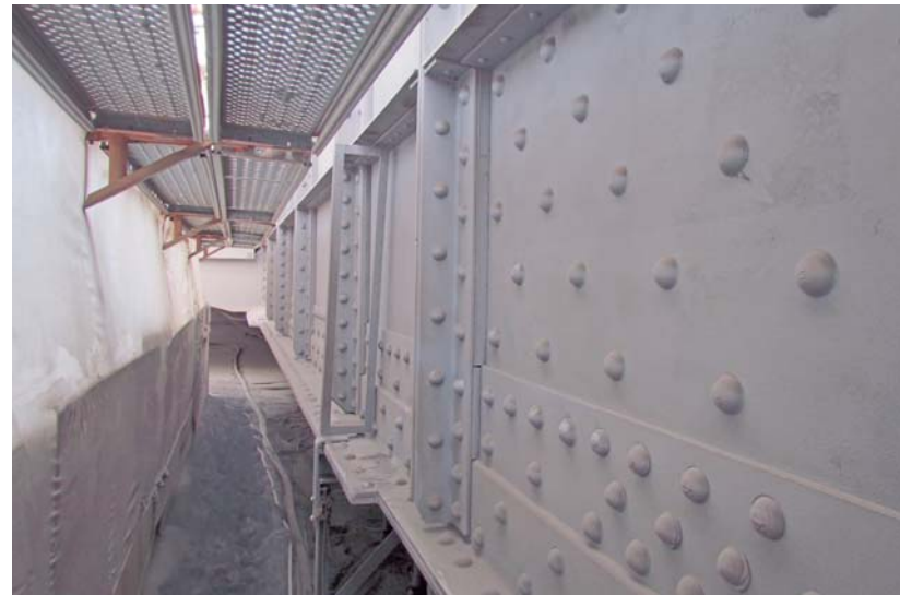
Stralen en spuiten vindt hier plaats terwijl het wandelend publiek op een meter afstand voorbij loopt
