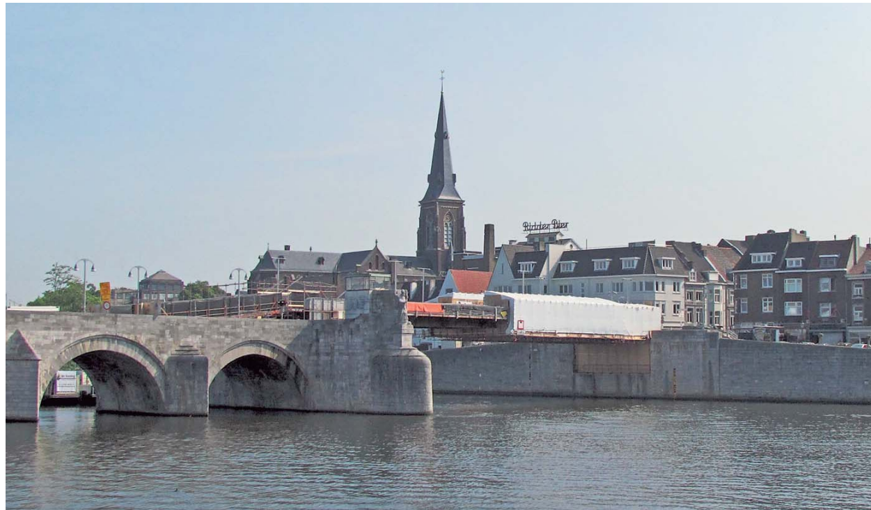
De conserveringsconstructie loopt onder de brug door. De loop- en fietsverbinding bovenop de brug bleef tijdens de werkzaamheden geopend
